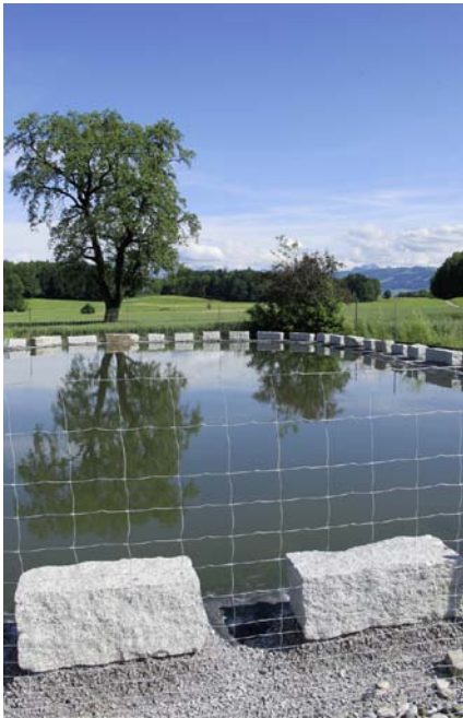
Natürliche Ressourcen werden sparsam genutzt: Das neue Regenwasserbecken in Grüningen fasst 1000 m 3 .
