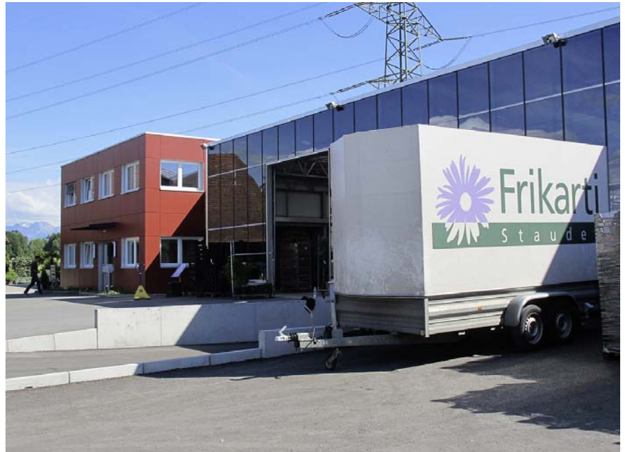
Arbeitsabläufe und Logistik sind seit diesem Frühjahr noch effizienter gestaltet: das neue, gut isolierte Bürogebäude mit grosszügiger Verladehalle und angegliedertem Gewächshaus.
